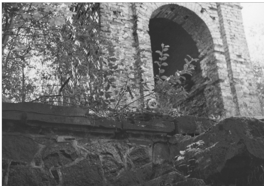
Ryc. 7. Mauzoleum rodziny von Schlieffen w Sulechówku. Fot. Z. Sobisz, 17.06.2004
